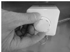
Pour éteindre le ventilateur, tournez le potentiomètre dans le sens inverse des aiguilles d'une montre jusqu'à ce que vous entendiez un clic.
