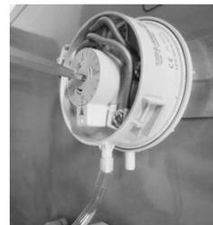
5. Allez vers la perte de charge finale recommandée par Camfil en utilisant le tournevis au centre du capteur de pression. Pour localiser le capteur, voir le schéma de la boîte de jonction (ci-dessus).
